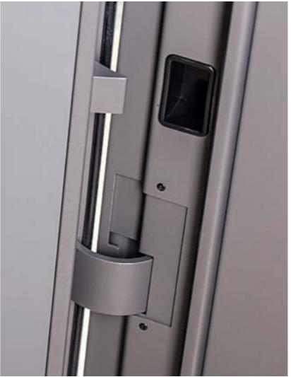
Detalles técnicos de calidad también para el nivel de entrada de nuestras puertas. marco con antipalancas fijos, embuticion de contención y cerradura con pestillos cilíndricos, brindan a la puerta Avant un estandar en calidad optimo y una gran robustez que alcanza la clase 3 antiefracción.
